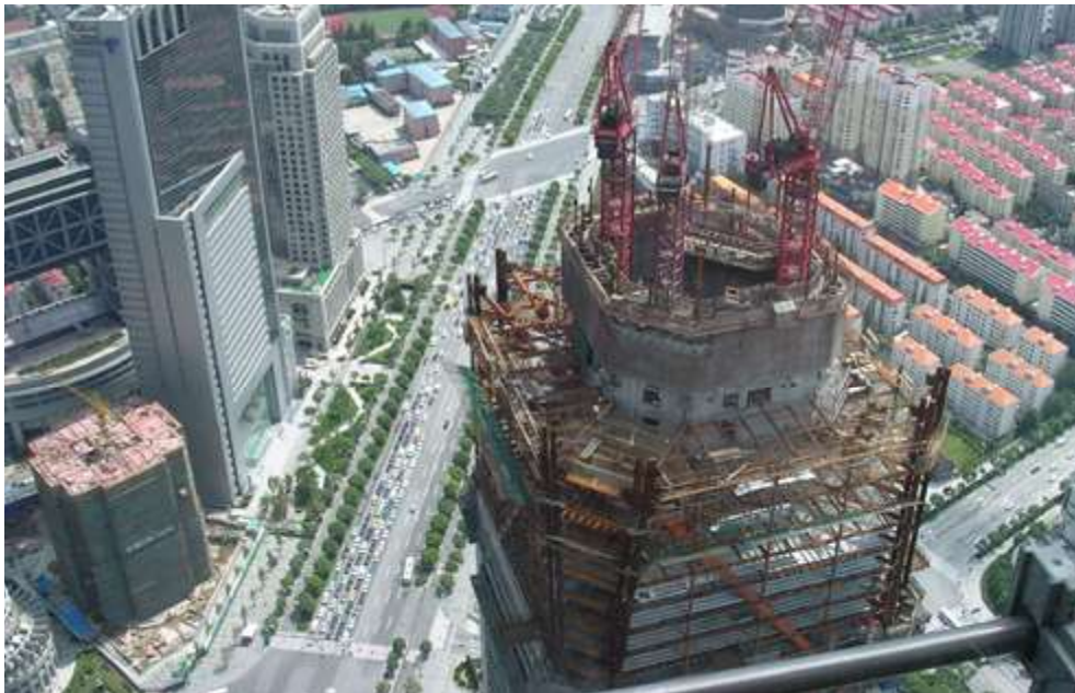
Rascacielos en construcción en el distrito de Pudong en Shanghai.
