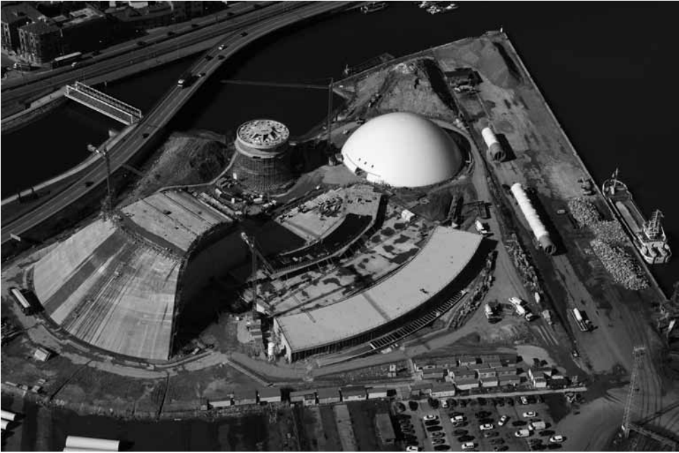
Obras de construcción del Centro Cultural Internacional Oscar Niemeyer, Avilés.
