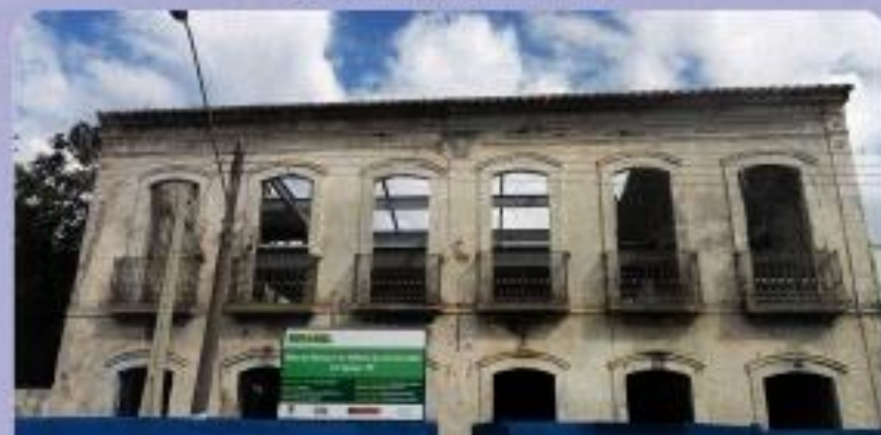
Obra do Prédio do Corneio Velho
